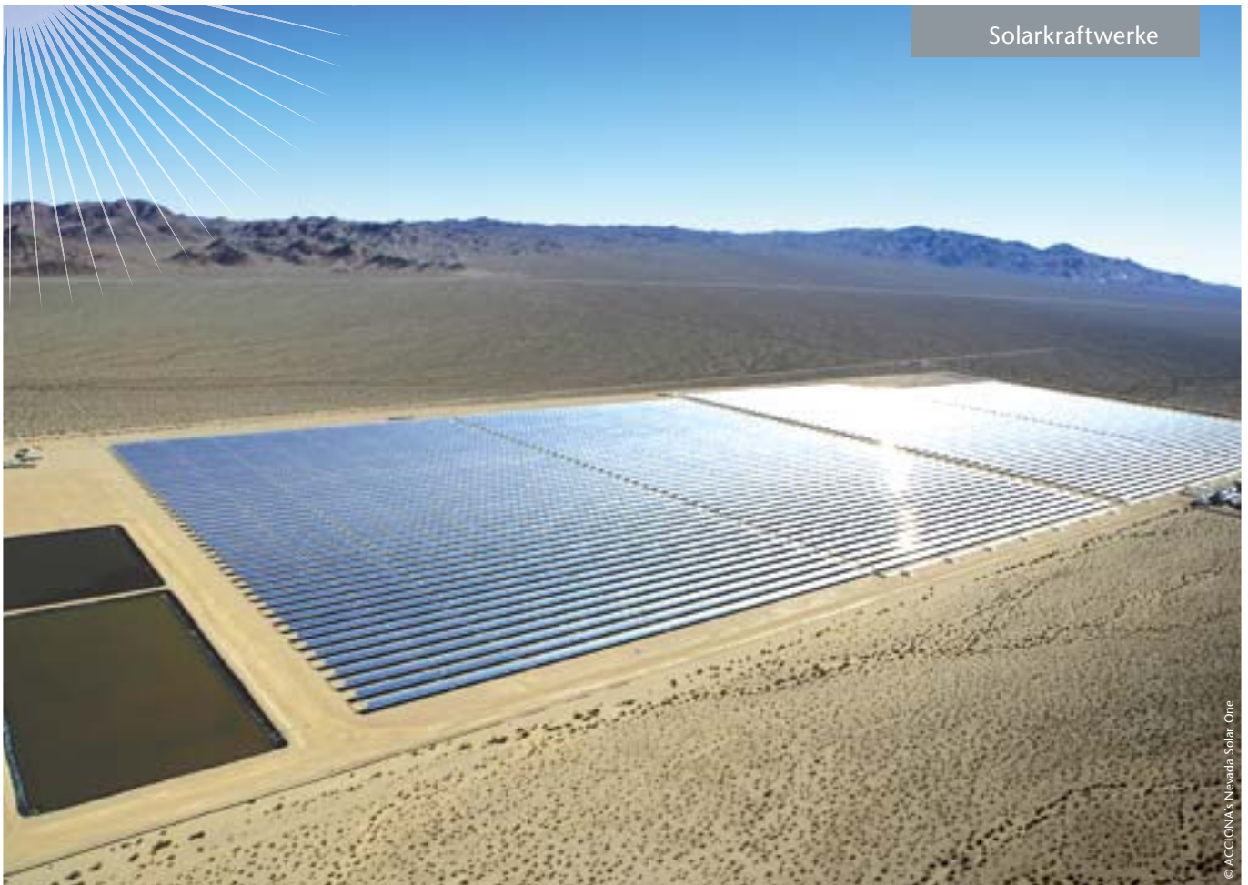
Das Solarkraftwerk ACCIONA Nevada Solar 1 wurde im Juni 2007 bei Boulder City, USA, installiert. Seine Leistung beträgt 64 MW. Mit 1,4 Mio m 2 ist es so groß wie 212 Fußballplätze.
