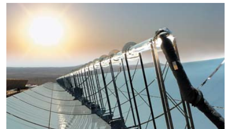
Das Solarkraftwerk ACCIONA Nevada Solar 1 wurde im Juni 2007 bei Boulder City, USA, installiert. Seine Leistung beträgt 64 MW. Mit 1,4 Mio m 2 ist es so groß wie 212 Fußballplätze.
